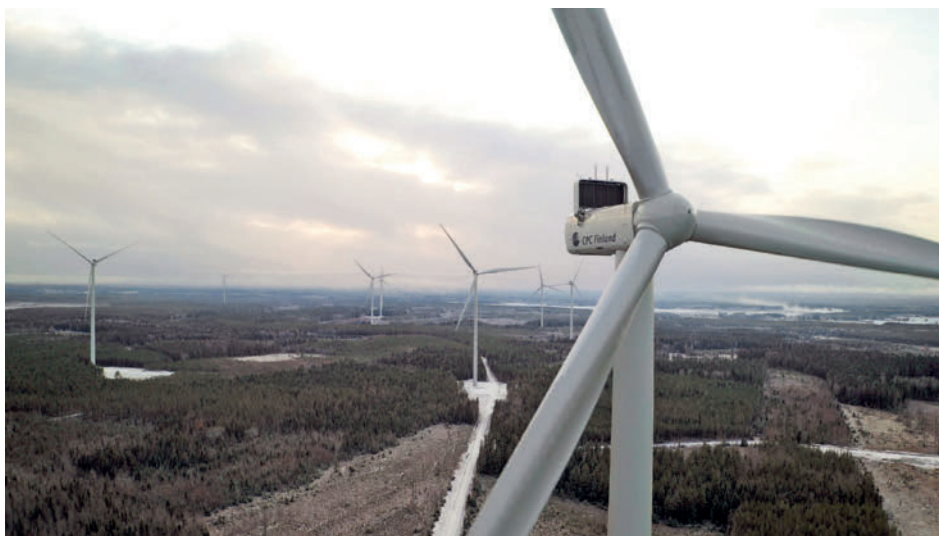
Bei Lappfjärd im Südosten Finnlands engagiert sich die Ärzteversorgung Westfalen-Lippe seit 2021 beim Bau und Betrieb eines Windparks. Die Fotos zeigen den benachbarten „Schwester“-Windpark Lakiakangas in der Region Österbotten.
